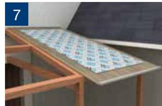
Disponga la primera plancha sobre la estructura, con la película protectora que indica el lado con protección UV hacia arriba.
