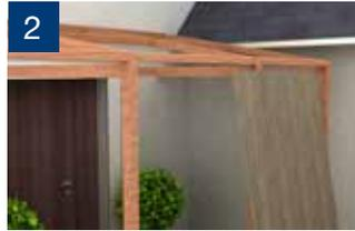
Para permitir un correcto drenaje del agua, la plancha se debe instalar siempre con los alveolos a favor de la pendiente.
