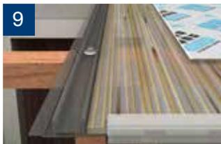
Fije la base del perfil HCP a la estructura. Asegúrese que los tornillos no se doblen ni se rompan y que no ejerzan demasiada presión.
