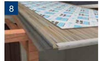
Para mantener la estanqueidad de los alveolos y evitar filtraciones, las planchas no se deben perforar. Para unir las entre sí, se utiliza el perfil HCP.
