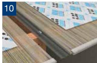
Una vez instalado el perfil, disponga la primera plancha de Polibambú sobre el lado izquierdo y la segunda plancha sobre el lado derecho.
