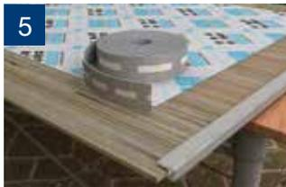
Selle ambos extremos de la plancha para evitar filtraciones. Para sellar el extremo superior utilizaremos cinta de aluminio más cubrezócalo.
