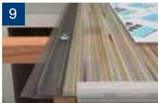
9 Fije la base del perfil HCP a la estructura. Asegúrese que los tornillos no se doblen ni se rompan y que no ejerzan demasiada presión.
