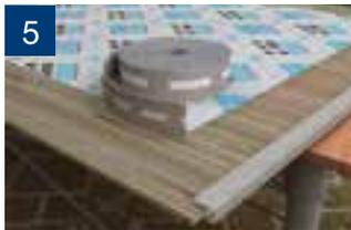
5 Selle ambos extremos de la plancha para evitar filtraciones. Para sellar el extremo superior utilizaremos cinta de aluminio más cubrezócalo.
