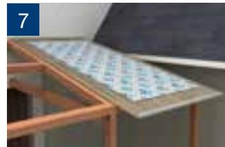
7 Disponga la primera plancha sobre la estructura, con la película protectora que indica el lado con protección UV hacia arriba.
