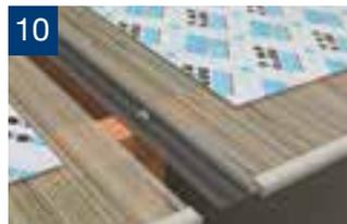
10 Una vez instalado el perfil, disponga la primera plancha de Polibambú sobre el lado izquierdo y la segunda plancha sobre el lado derecho.
