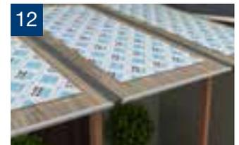
12 Continúe agregando secuencialmente: Un perfil base, una plancha y una tapa, hasta llegar al final de la estructura.
