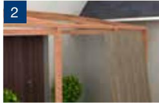
2 Para permitir un correcto drenaje del agua, la plancha se debe instalar siempre con los alveolos a favor de la pendiente.
