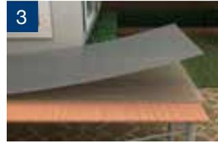
3 Retire la película protectora de color gris de la plancha, dejando esta cara del Polibambú totalmente descubierta.
