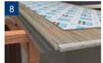
8 Para mantener la estanqueidad de los alveolos y evitar filtraciones, las planchas no se deben perforar. Para unir las entre sí, se utiliza el perfil HCP.
