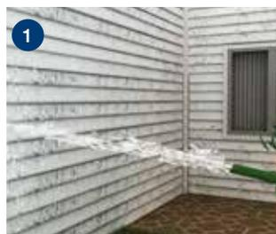
1. Moje el revestimiento con unamanguera o con una hidrolavadora. Con esto soltaremos el un poco el polvo adherido.
