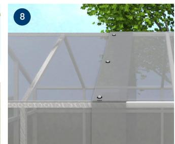
Cubrir toda la estructura dejando una distancia entre las fijaciones de 15cm en los bordes, y de 30cm en el interior de la cubierta.
