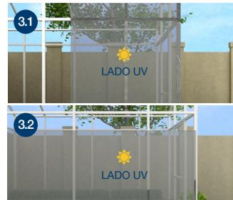
Presente el rollo de policarbonato sobre la estructura en sentido vertical (3.1) u horizontal (3.2). Deje la cara que contiene Filtro UV hacia el exterior.
